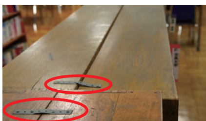
写真 1. 棚同士の連結による固定の例
