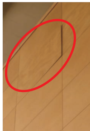
写真 5. 内壁のずれ
