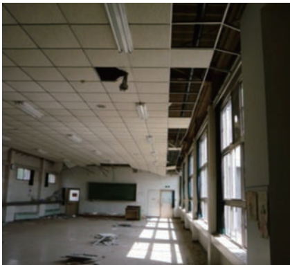
写真1. 壁際の破損
