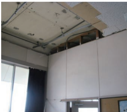
写真 1. 壁際の破損
