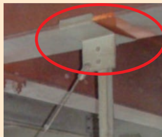
写真1. クランプ類の滑りの例 2)
