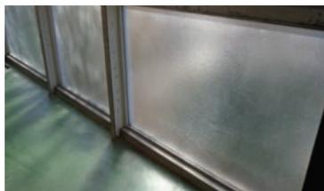
写真 1. 硬化性パテで固定された FIX 窓
