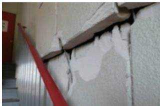
写真2. 地震によるALCパネルの被害例
