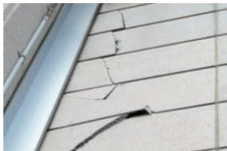
写真3. 地震による押出成形セメント板の被害例
