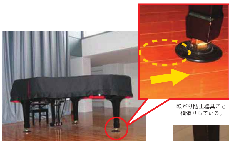
写真1. 地震の揺れによる横滑り
