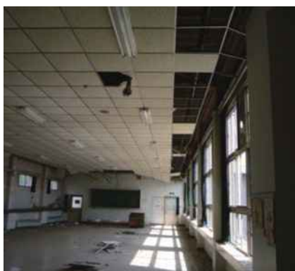
写真 1. 壁際の破損
