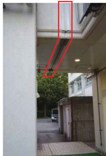
写真 2. 通路の上部にある エキスパンション・ジョイント
