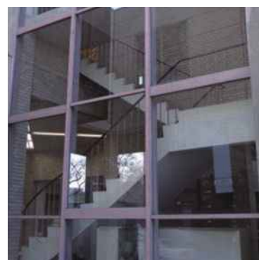
写真 2. 硬化性パテで固定された FIX 窓
