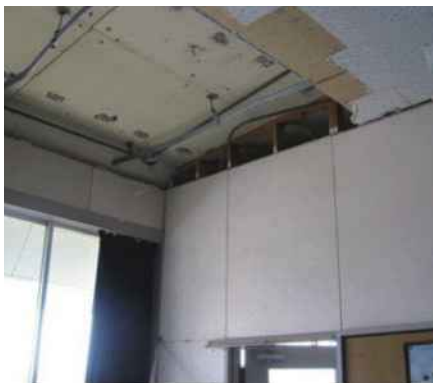
写真 1. 壁際の破損
