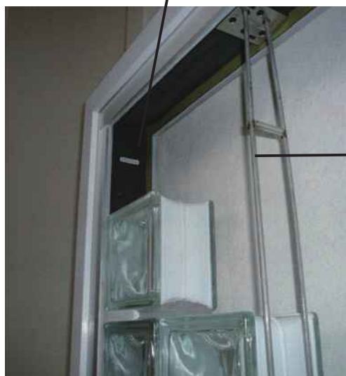
写真 3. 現在の工法による施工状況 12)
