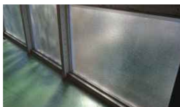
写真 1. 硬化性パテで固定された FIX 窓
