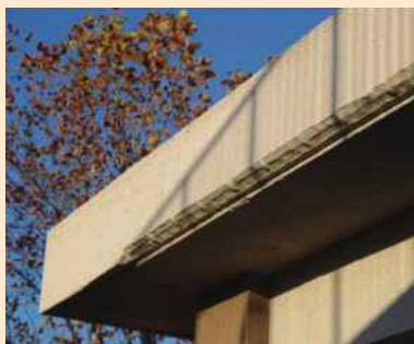
写真 4. 補修例（はつり後、塗装仕上げ）
