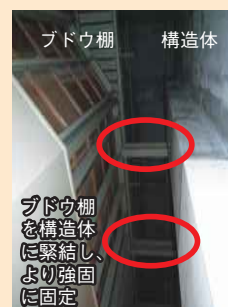
写真3. ブドウ棚天井と構造体の緊結（下からの見上げ）
