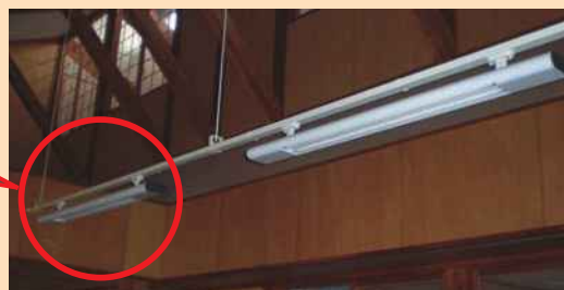
写真 1. レースウェイ取付け照明器具
