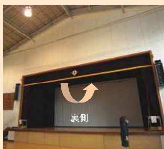
写真1. 屋内運動場のステージ
