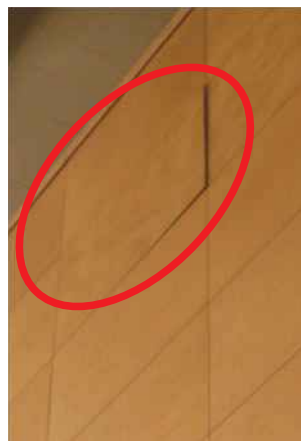
写真 5. 内壁のずれ
