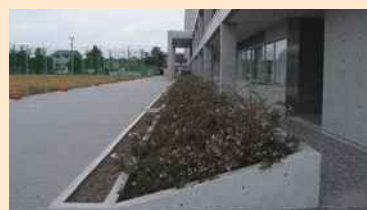
写真 1. 頭上にガラス等が落下しないための工夫（植栽の配置）の例
