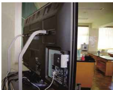
写真 1. 薄型テレビの固定の例
