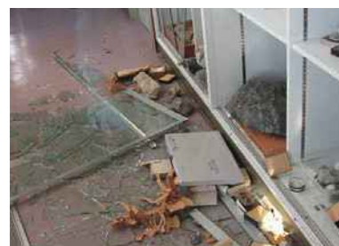
写真 3. 収納物が飛び出しガラスが飛散した例
