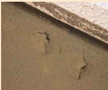
写真 1. 塗料の浮き
