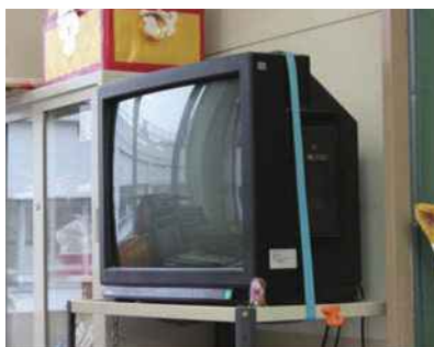
写真 2. ベルトによる固定の例
