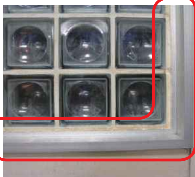
写真 1. 現在の工法によるガラスブロック壁 （四周に緩衝材を設置）
