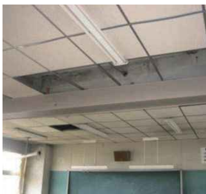
写真 2. 梁際の破損
