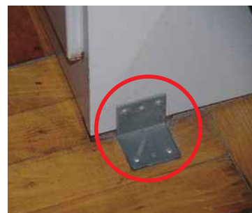
写真 2. 棚の下部を床に固定した例
