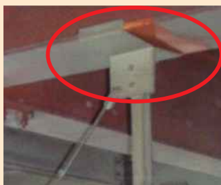
写真1. クランプ類の滑りの例 2)
