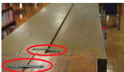
写真 1. 棚同士の連結による固定の例
