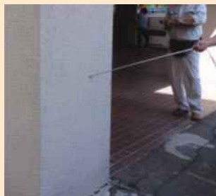
写真1. 打診調査状況
