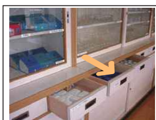
写真 2. 震動により開いた引き出しの例
