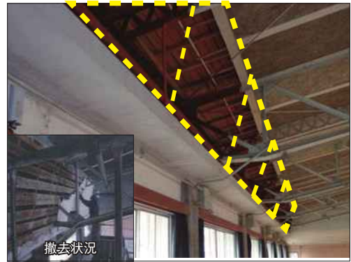
写真1. 下がり壁（点線で囲った部分）撤去後
