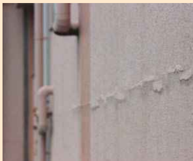
写真 2. 塗料の浮き
