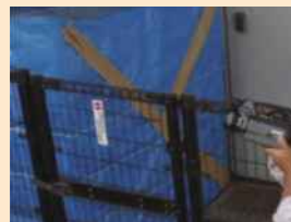
写真2. 赤外線調査 (赤外線カメラを用いて外壁の温度分布を測定し、異常個所を発見する方法)
